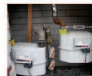
Impulzný výstup plynometra so samostatným rádiovým vysielateľom
